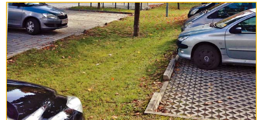
1 Rasenmulde mit Humusfilter Parkplatzentwässerung über eine Sickermulde
