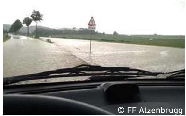
Abb. 4: Fließweg quert Bundesstraße, die Überströmungsstelle ist auf der Fließwegekarte nicht ersichtlich
