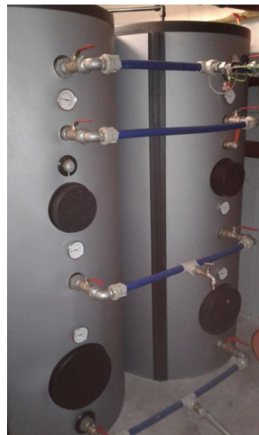
Abb.7) Zwei Pufferspeicher aus Edelstahl (Sp2)
