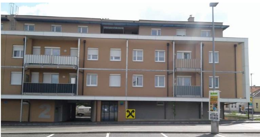
Abb.3) Wohngebäude der SGN mit Pilotanlage zur Grauwasserwärmerückgewinnung
