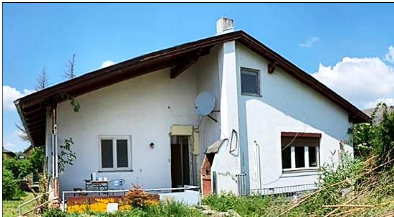
Grafik 18: Eigenheim 1220 Wien vor der Sanierung
