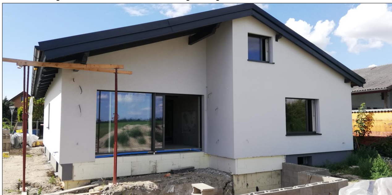
Grafik 20: Eigenheim 1220 Wien kurz vor Fertigstellung
