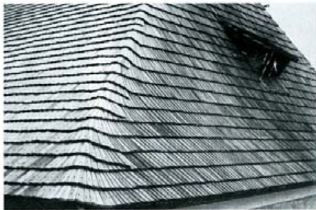
Grat eines Schindeldaches
