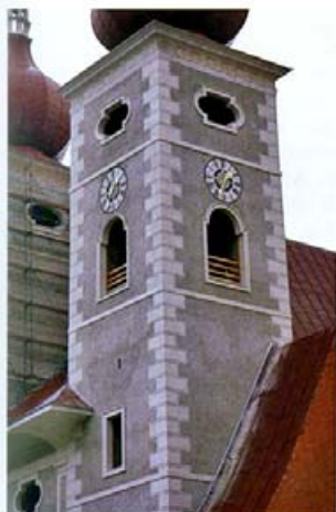
St. Lambrecht/Stmk., Stifiskirche, Verputz von Seicassia, um 1650, Nullfläche Naturputz, rauh, Eckquaderungen Nagelriss und Sgraffito
