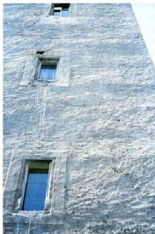
Krems, Passauer Hof, Turm, um 1300, unberührt erhaltener Naturputz mit Fensterfaschen und Fugenmalerei
