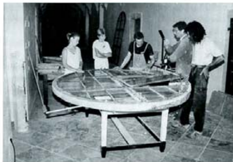
Instandsetzung eines alten Fensters
