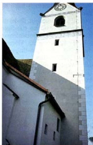
St. Donat/Ktn., Pfarrkirche. Der Neuverputz mit gefluchteten Kanten und eingebneter Fläche läßt den Unterschied zwischen Original und Kopie verschwinden
