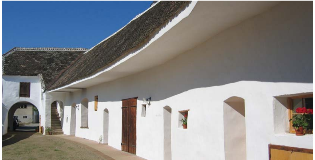
Radlbrunn, „Brandlhof“, Innenhof
