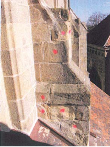
Tulln, Pfarrkirche, Chorfassade, Schadensbild
