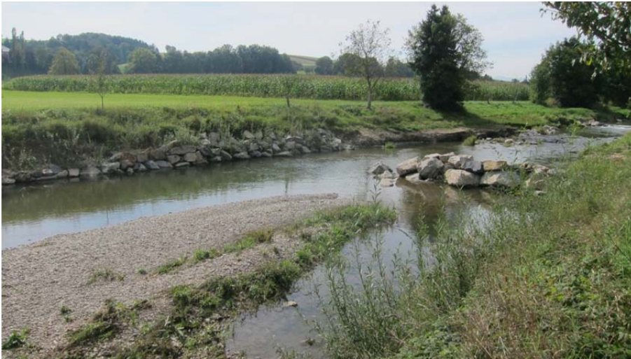
Abbildung 16: Bühnenstrecke bei Hofstetten, Bereich obere Bühne mit leeseitiger Kiesbank
