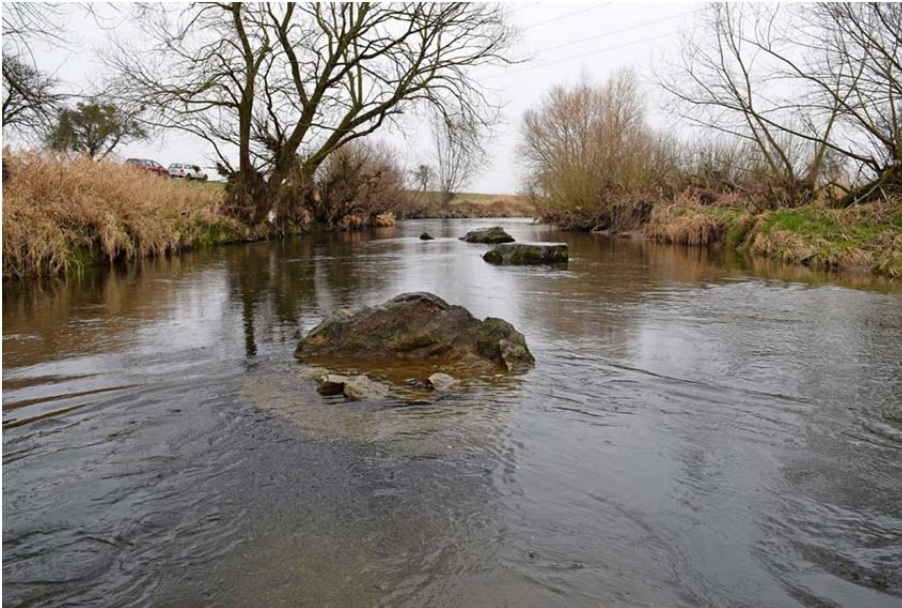
Abbildung 6: Störsteine in der Renaturierungsstrecke bei Au
