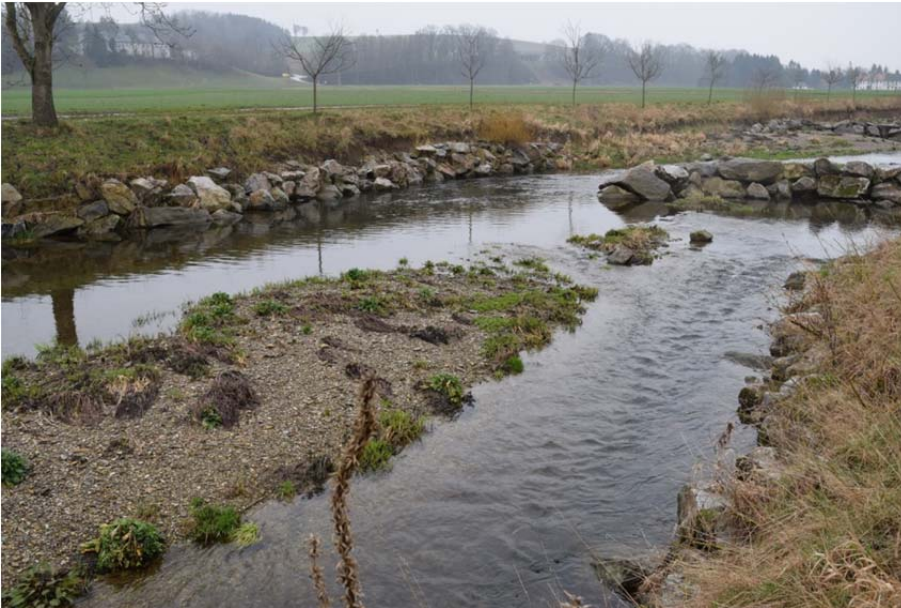
Abbildung 18: Bühnenstrecke bei Hofstetten, Bereich flussab unterer Sichelbühne mit tiefliegender, hinterströmter Kiesbank
