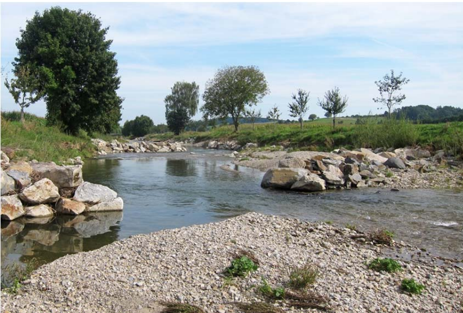
Abbildung 17: Bühnenstrecke bei Hofstetten, Bereich mittlere Bühne mit inklinanter Bühne rechts und flussauf versetzter Kurzbühne links
