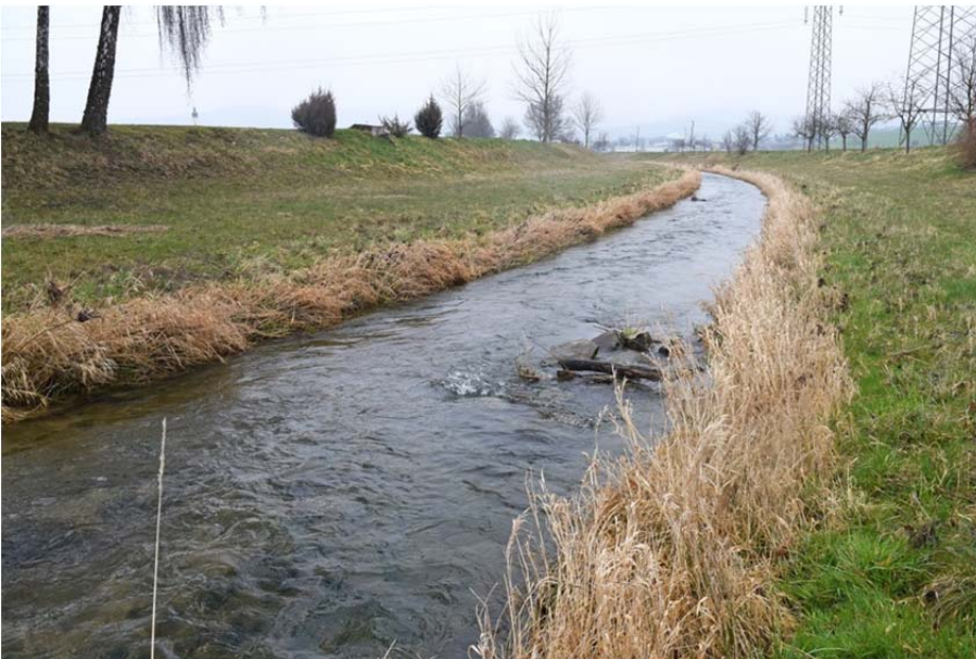
Abbildung 12: Regulierungsstrecke bei Rottenhof.
