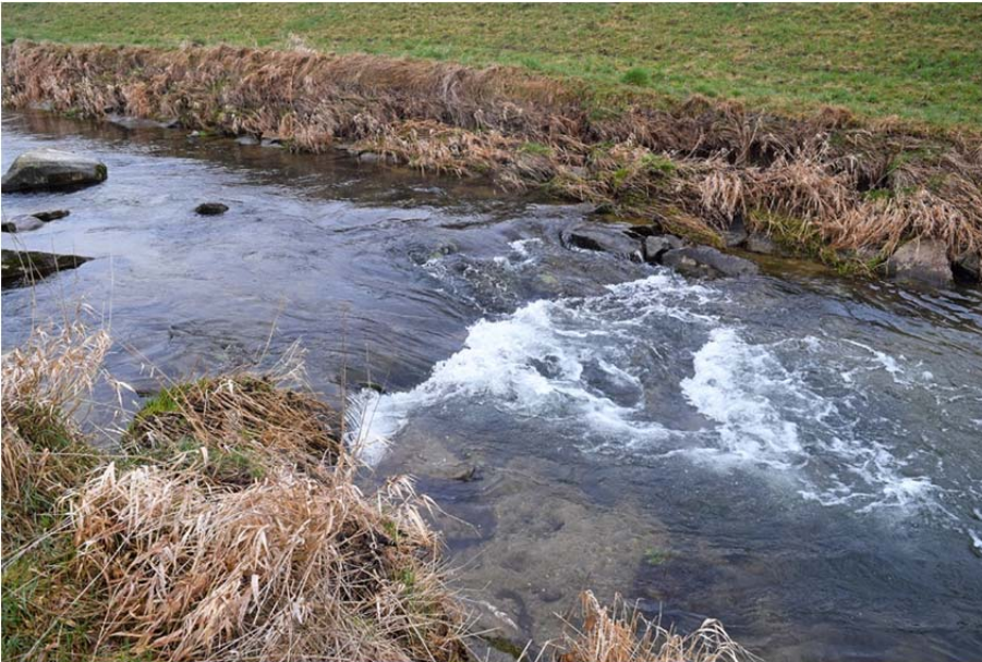
Abbildung 22: Gut fischpassierbare, aufgelöste Schwelle bei Fluss-km 3,75.
