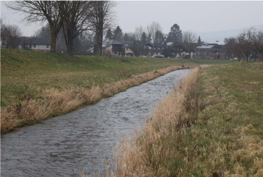
Abbildung 61: Doppeltrapezprofil der Melk flussauf Ruprechtshofen
