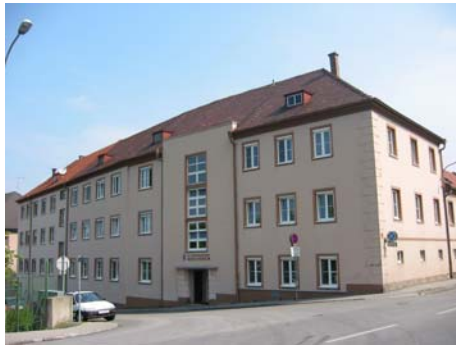
Foto 1 Pflegetrakt- Altbau strassenseitig
