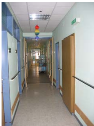
Foto 5 Flursituation, alter Trakt
