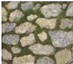
Abbildung 29 Beispielfoto: begrünbarer Steinsatz an der Überfallskante
