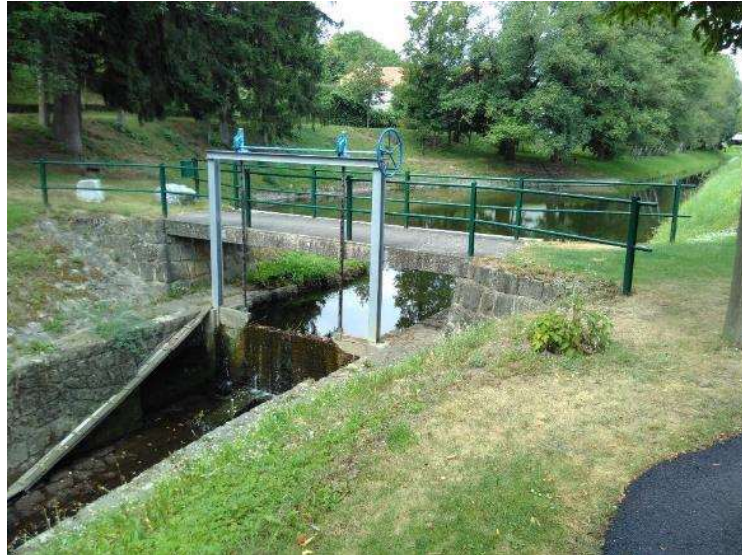
Abbildung 6 Loisbach, Löschteich mit Schütz
