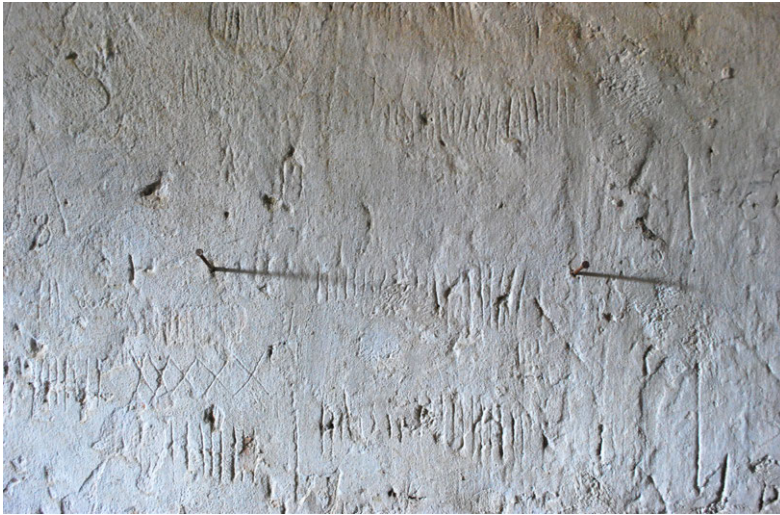
Wand im Keller von Schloss Stetteldorf (links)
