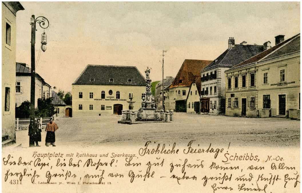
Der Scheibbser Rathausplatz auf einer zeitgenössischen Postkarte. Der Beleuchtungskörper hängt an einem Ausleger und kann zum Nachstellen der Kohlepresstäbe an Seilen heruntergelassen werden.
