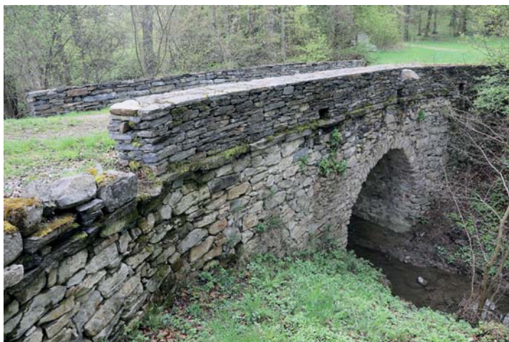
Lanzing, sogenannte „Römerbrücke“
