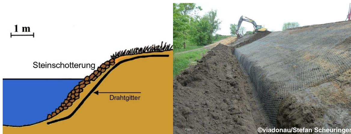
**RICHTIG: Ufersicherung mit aufgelegten, korrosionsbeständigen Drahtgitter (aus Nitsche 2003, Links); Verlegung eines Drahtgitters an Hochwasserschutzdamm (Rechts)**
