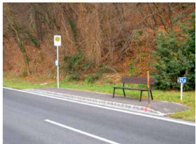
Auch kleinste Haltestellen sind gemäß dem Stand der Technik zu errichten.
