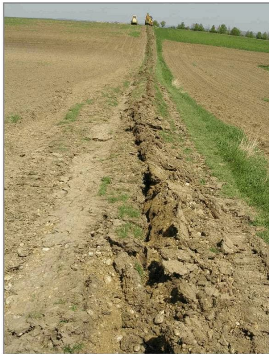
Pflugverlegung: Der Eingriff ist vergleichsweise gering
