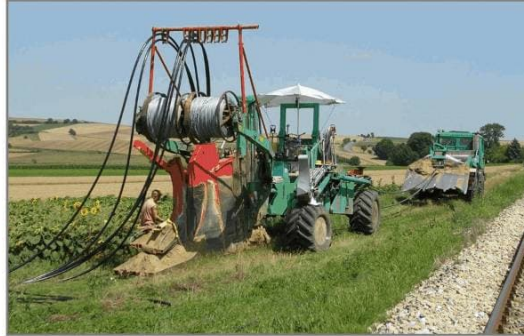
Pflug-Tross: Verpflügung mit ausgelegten Kabeln
