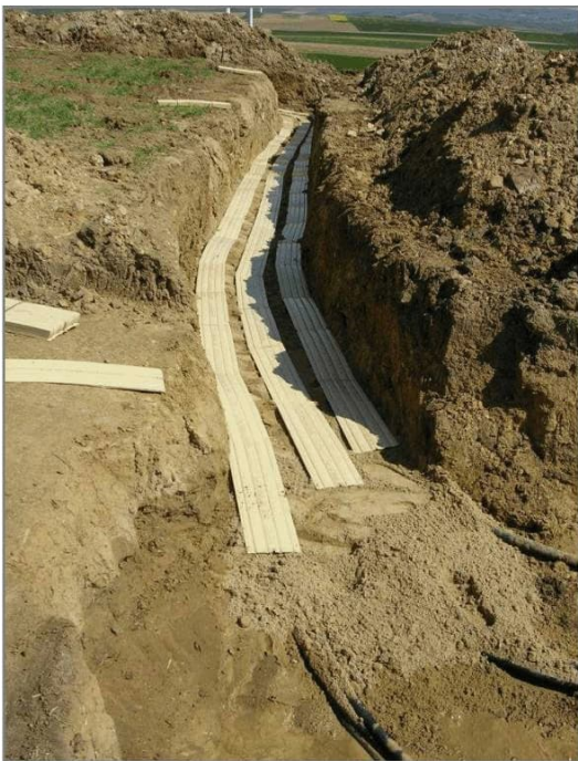
Verlegung durch Graben einer Künette
