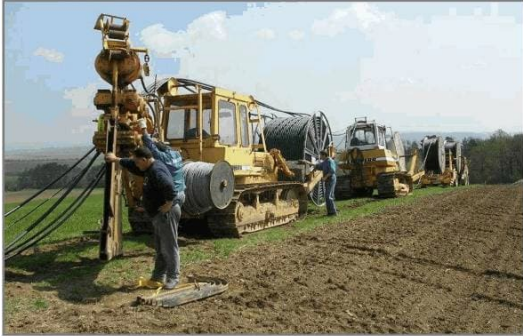
Pflug-Tross: Verpflügung direkt von den Kabeltrommeln
