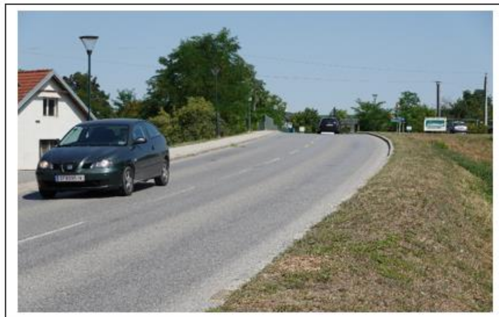
Abbildung 21: Straßenüberführung in Mannersdorf
