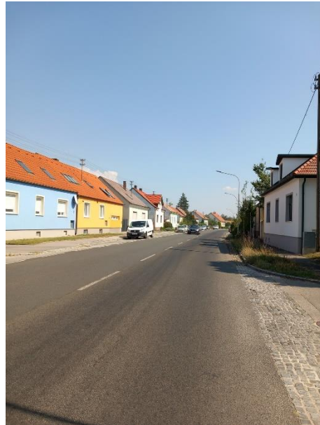
Ortskern – Hauptstraße (eigene Aufnahme)
