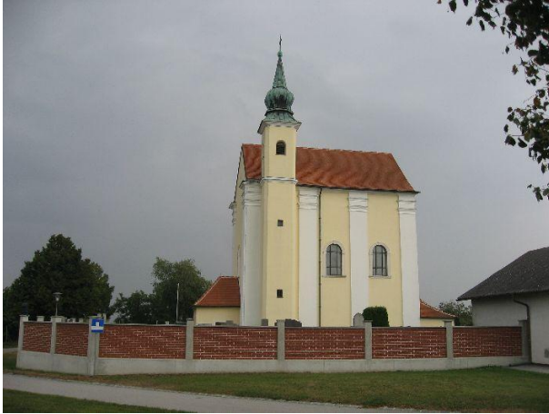
Kirche in Regelsbrunn (Quelle: eigene Aufnahme)
