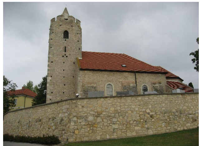
Kirche von Scharndorf in erhöhter Position (Quelle: eigene Aufnahme)
