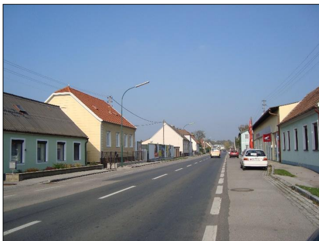
Hauptstraße, Blick Richtung Norden (Quelle: eigene Aufnahme)
