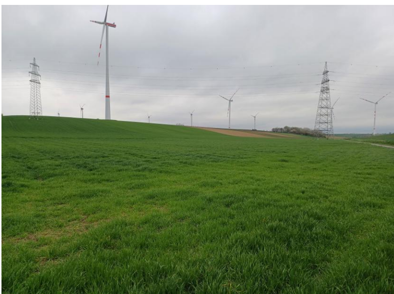
WEA GKA II-4: Blick in Richtung Westen auf die bestehende 220 kV-Leitung sowie eine bestehende WEA des WP Großkrut-Altlichtenwarth
