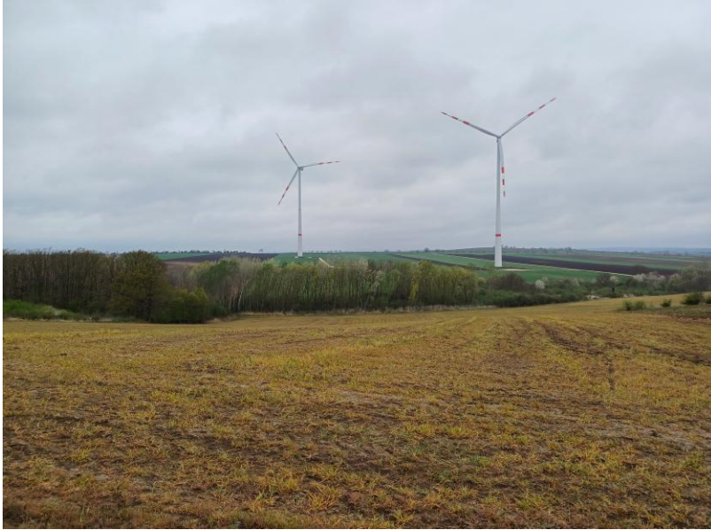
WEA GKA II-3: Blick vom ungefähren WEA-Standort in Richtung Osten und zwei bestehende WEA des WP Großkrut-Altlichtenwarth
