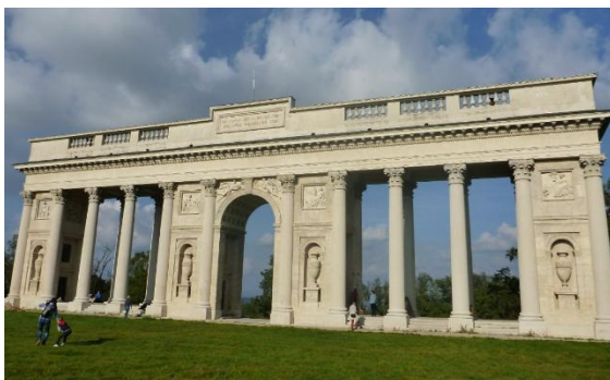
Reistenkolonnade (Quelle: Einreichoperat Einlage D.03.06.00-01)
