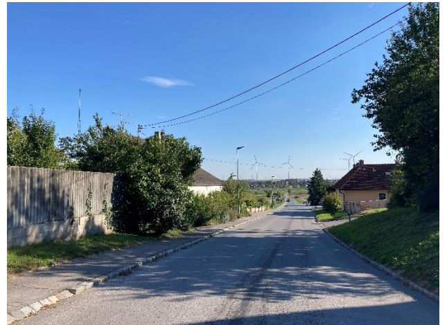
Südlich Orteinfahrt St. Ulrich, Blick Richtung Vorhabensgebiet
