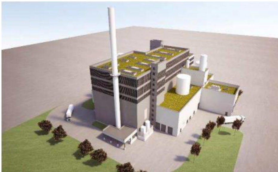
3 D Ansicht des geplanten Wirbelschichtofens Dürnrohr
