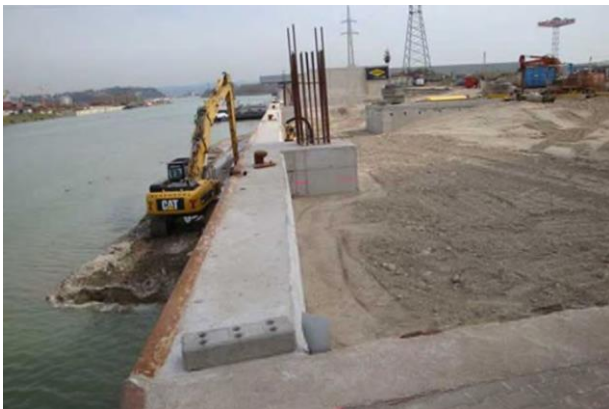
Abbildung 17: Errichtung Ennschafen Kaianlage 1 (Quelle / https://www.ennshafen.at/geschichte/ )
