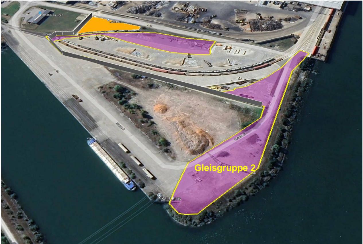
Abbildung 9: : Schrägluftbild Blickrichtung Süd-West auf die Vorhabensflächen (magenta= Erweiterungsbe- reich - UVP-Vorhaben (Lagerausbau und Gleisgruppe 2)) mit 3D-modellierter Sicht- und Lärmschutzmauer (modelliert mit 6 m Höhe) gem. Bestand September 2024 (Quelle: Google Earth, Einreichoperat, Einlage B.01.104, eigene Bearbeitung )
