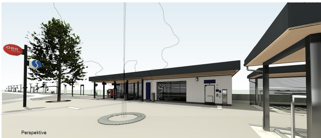
Abbildung 1: Ansicht Aufnahmegebäude Bf. Horn (Ausschnitt Einlage 460_02)
