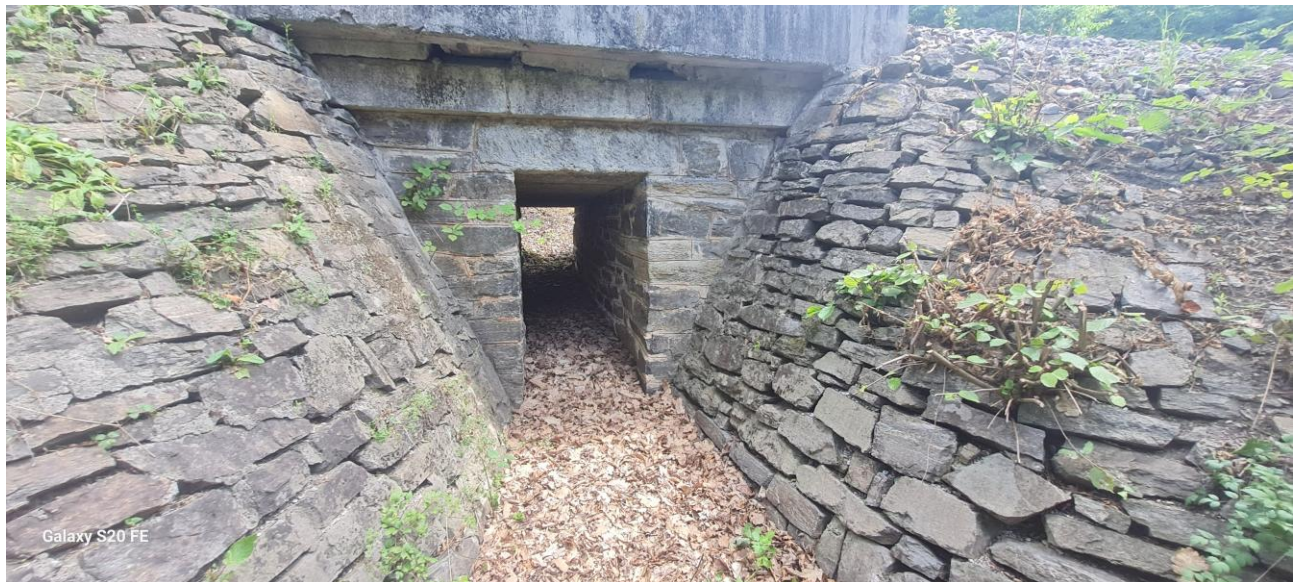
Abbildung 5: Beispiel für einen Bestandesdurchlass unter der Eisenbahntrasse (km 38,16)
