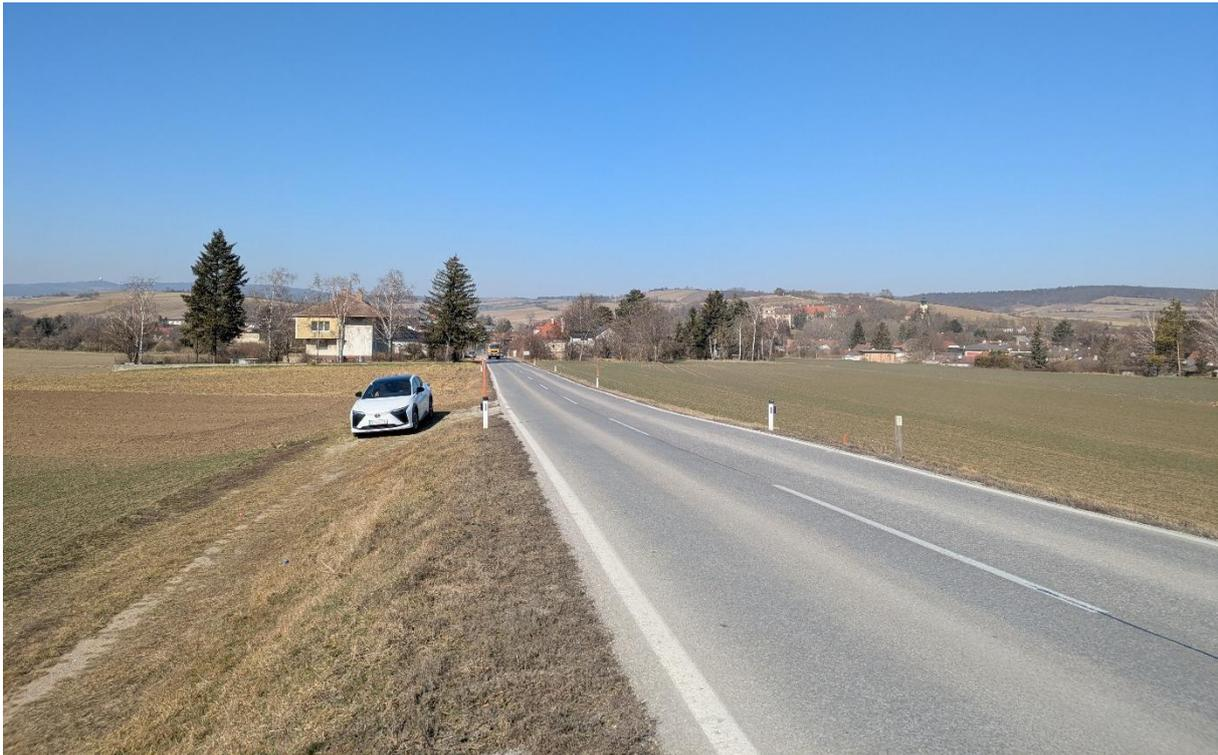
Abbildung 6: Anfahrsichtweite bei Windpark Einfahrt an der L10, Blickrichtung Norden: ca. 140 m (Quelle: eigene Aufnahme, Aufnahmedatum: 05.03.2025)
