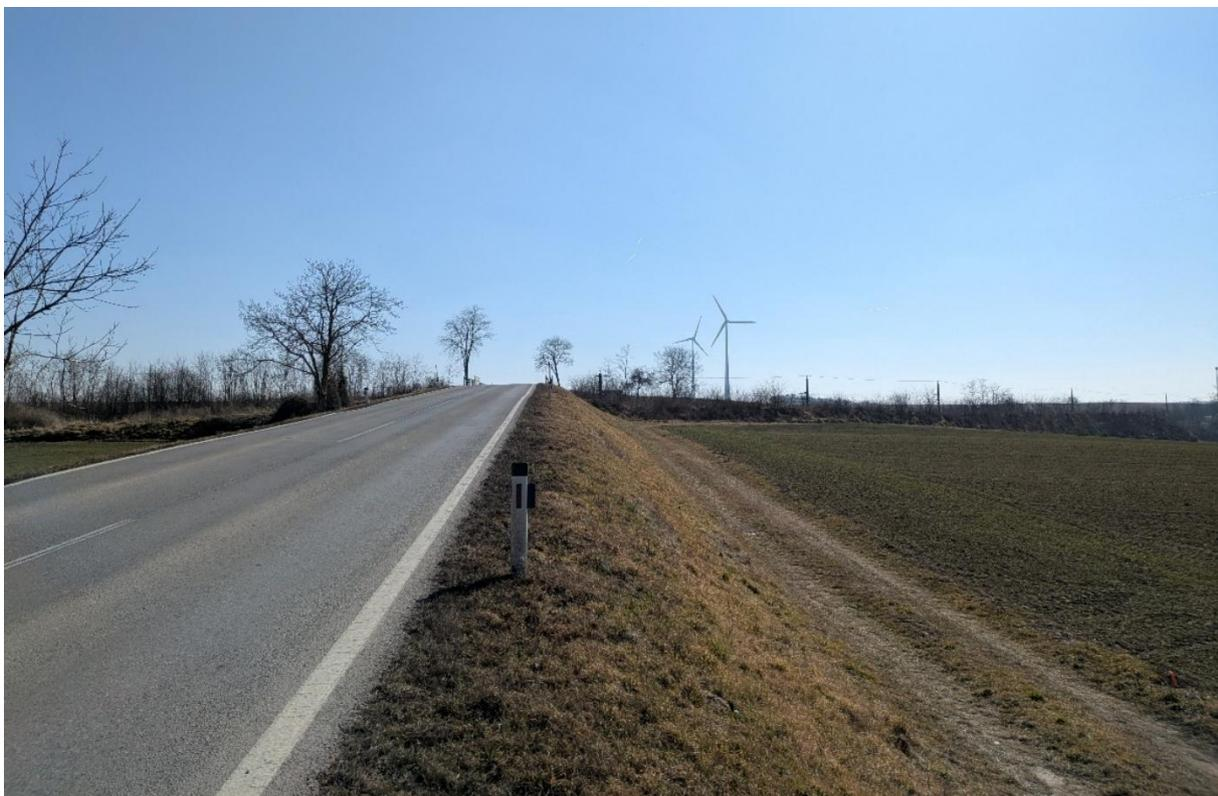
Abbildung 7: Anfahrsichtweite bei Windpark Einfahrt an der L10, Blickrichtung Süden: ca. 100m (Quelle: eigene Aufnahme, Aufnahmedatum: 05.03.2025)
