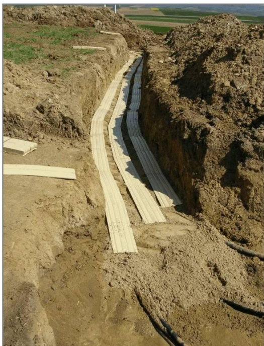
Verlegung durch Graben einer Künette
