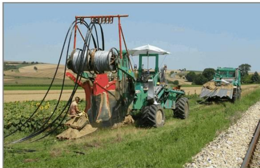
Pflug-Tross: Verpflügung mit ausgelegten Kabeln
