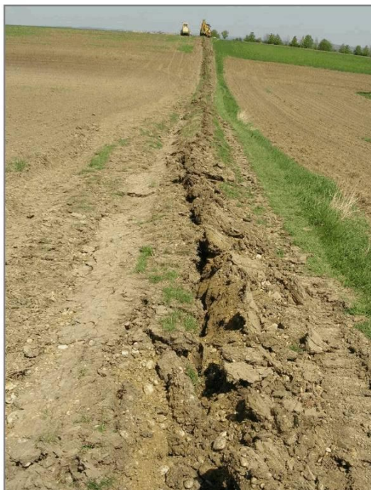
Pflugverlegung: Der Eingriff ist vergleichsweise gering
