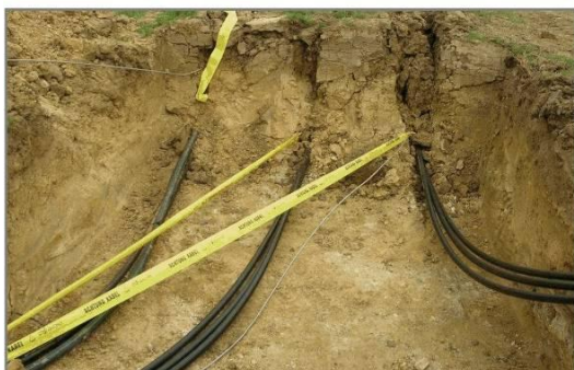
Übergang Pflugverlegung - Künette
