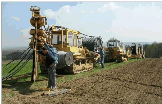
Pflug-Tross: Verpflügung direkt von den Kabeltrommeln
