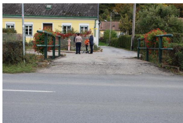
Foto 92: Eine der Brücken über den Kehrbach in Hochleithen
