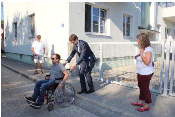
Foto 143: Foto von einer viel zu steilen Gehsteigabschrägung
