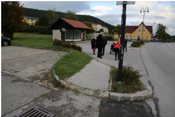
Foto 56: Beispielfoto für eine nicht normgerechte Gehsteigabsenkung in Höflein a.d. hohen Wand
