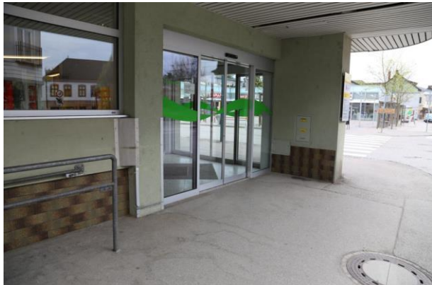
Foto 104: Das Kaufhaus Zeitlhofer in Loosdorf ist barrierefrei zugänglich.
