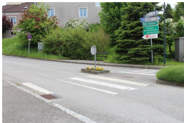
Foto 132: Ein weiterer Straßenübergang, der nicht der RVS 02.02.36 entspricht
