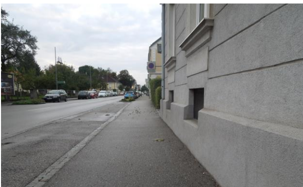
Foto 72: Beispielfoto für einen ausreichend breiten Gehweg mit gut nutzbarem Belag
