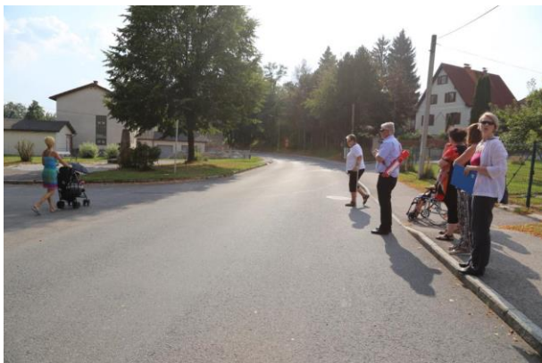
Foto 16: Beispielfoto für das Fehlen einer entsprechenden Gehsteigabsenkung auf einer Seite
