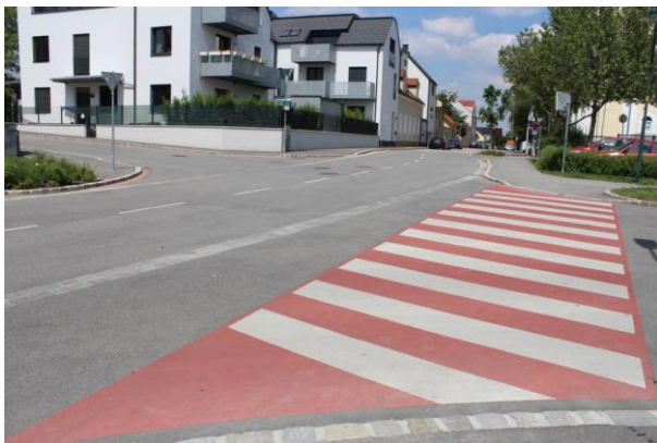
Foto 145: Beispielfoto für normgerechte Gehsteigabsenkungen im Kreuzungsbereich
