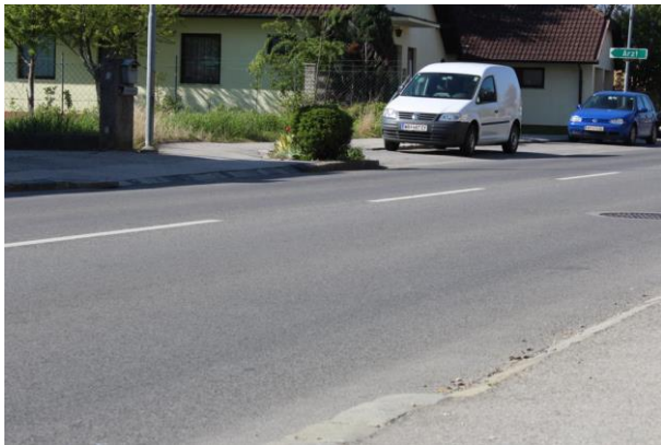
Foto 121: Beidseitig zu steil ausgeführte Gehsteigabschrägungen
