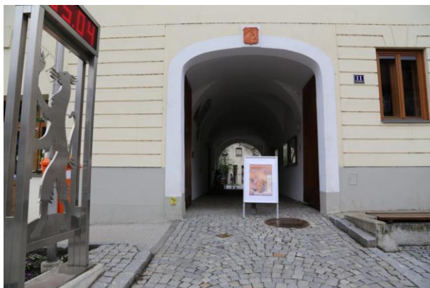
Foto 99: Zugang zum Gemeindeamt in Loosdorf. Eine Steigung von 12% und ein Kopfsteinpflaster erschweren den Zugang
