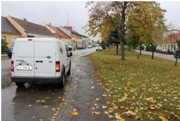
Foto 82: Beispielfoto für einen zu schmalen Gehweg mit schlecht nutzbarer Oberfläche
