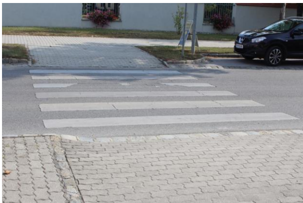
Foto 36: Beispielfoto für eine normgerechte Gehsteigabsenkung auf beiden Seiten bei einem Schutzweg
