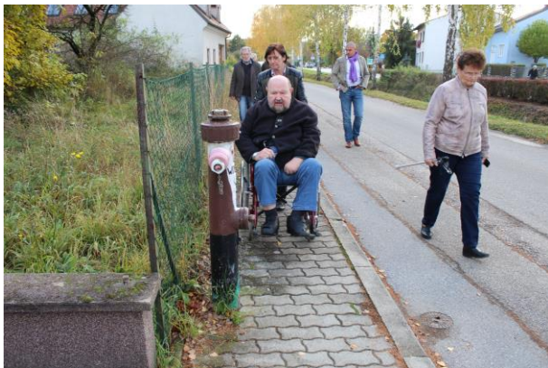
Foto 93: Beispielfoto für einen schmalen Gehsteig, der durch einen Hydranten zusätzlich eingeengt wird
