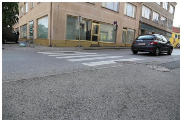
Foto 17: Beispielfoto für zu steile Gehsteigabschrägungen bei einem Schutzweg
