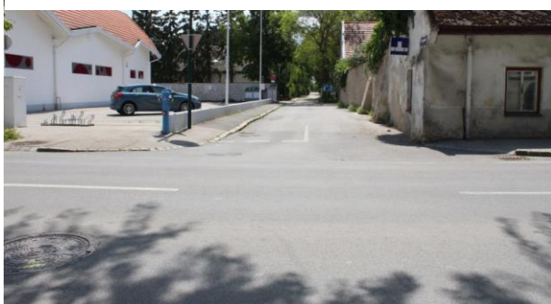
Foto 142: Foto von zu steilen Gehsteigabschrägungen und ausgeprägten Quergefällen
