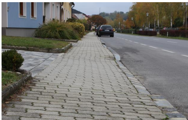
Foto 89: Beispielfoto für die Quergefälle in der Gemeinde Hochleithen
