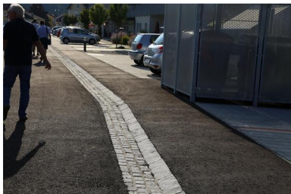
Foto 8: Beispielfoto für zu steile Gehsteigabschrägungen
