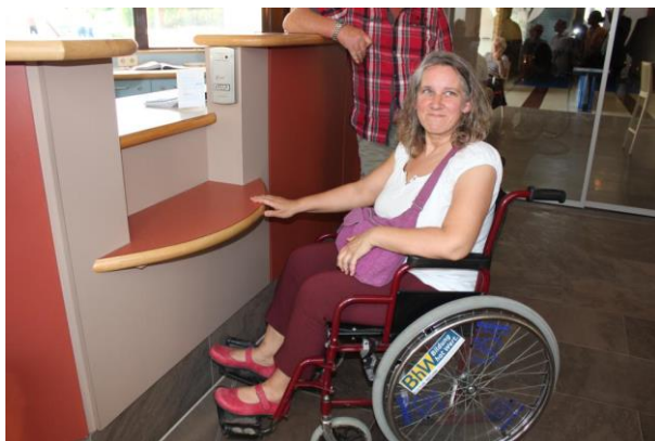
Foto 147: Ein abgesenkter Schalterbereich
