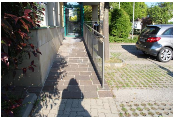
Foto 138: Die Rampe zur Bankfiliale in Biedermannsdorf
