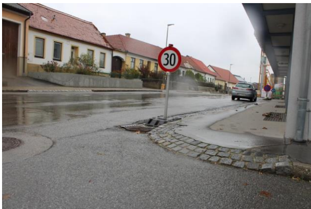
Foto 78: Die Gehsteigabschrägung am Weg zu Bank in Großkrut
