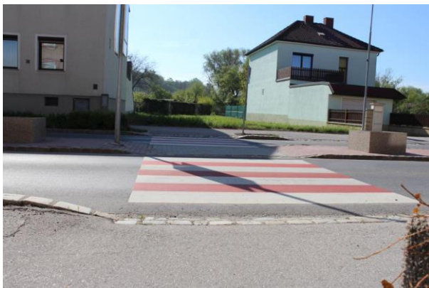
Foto 122: Eine normgerechte Straßenquerung mit Schutzweg
