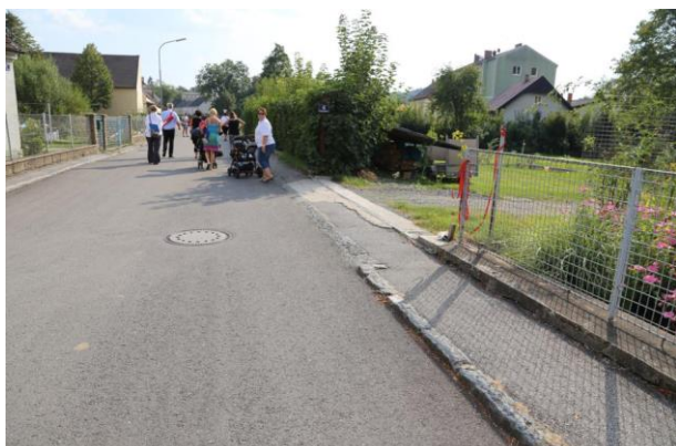
Foto 18: Beispielfoto für einen zu schmalen Gehsteig in Allentsteig
