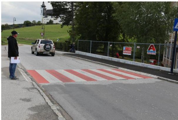
Foto 58: Beispielfoto für zu steile Gehsteigabschrägungen in der Gemeinde Höflein a.d. hohen Wand
