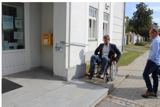
Foto 29: Die Rampe zum Rathaus von Bad Pirawarth
