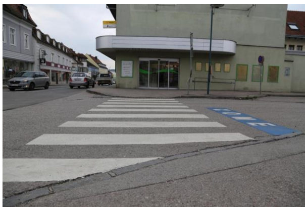
Foto 109: Bei Schutzwegen sind die Gehsteigabsenkungen zum überwiegenden Teil schon gemäß RVS 02.02.36 ausgeführt.
