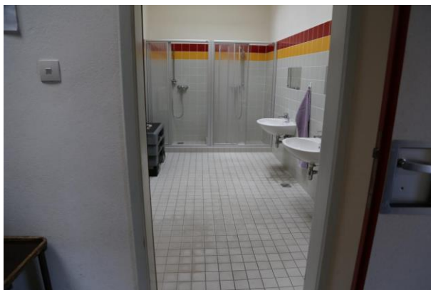
Foto 61: Der Duschbereich in der Volksschule in Höflein a.d. hohen Wand
